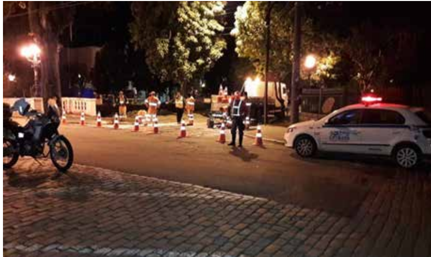
222 SERVIÇO DE SINALIZAÇÃO NO CENTRO
