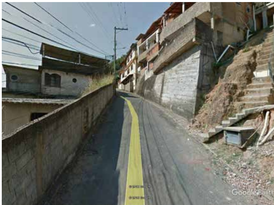
185 RUA ANANIAS DE MORAIS, BAIRRO CORRÊAS – VIA LOCAL.
