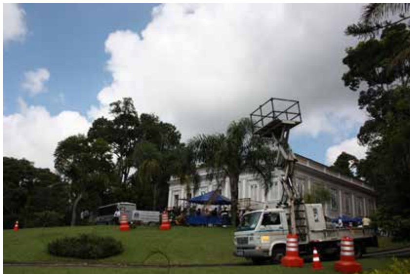
22129 EQUIPAMENTOS PRÓPRIOS DE SINALIZAÇÃO NA CMTT 2018
