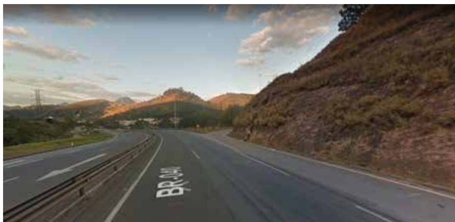
205 TRECHO DE ALÇA DE ACESSO FUTURA PARA ESTRADA DO CATOBIRA FONTE: GOOGLE MAPS
